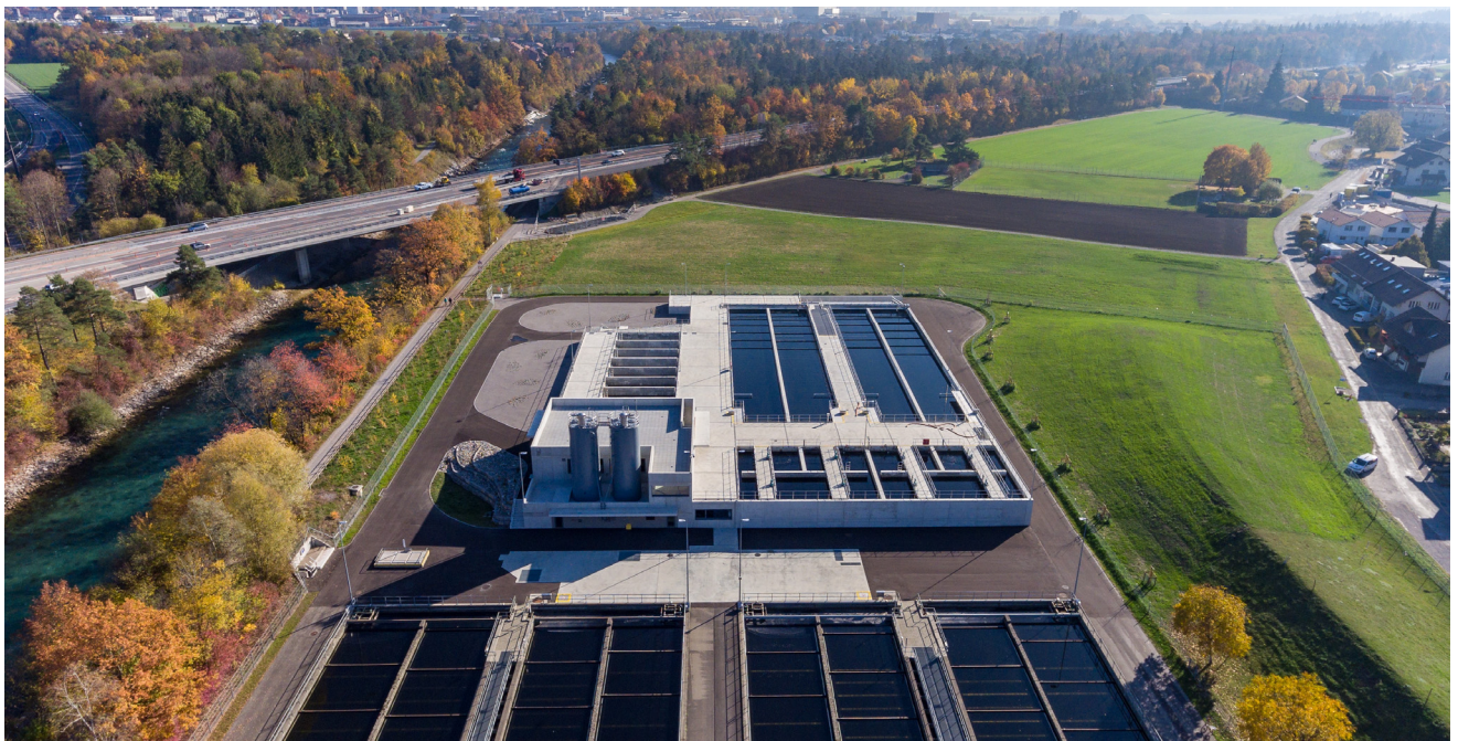
Abbildung 2: Luftansicht des neuen Anlageteils
