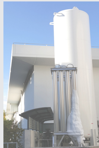
Reinsauerstofftank mit Verdampfer
