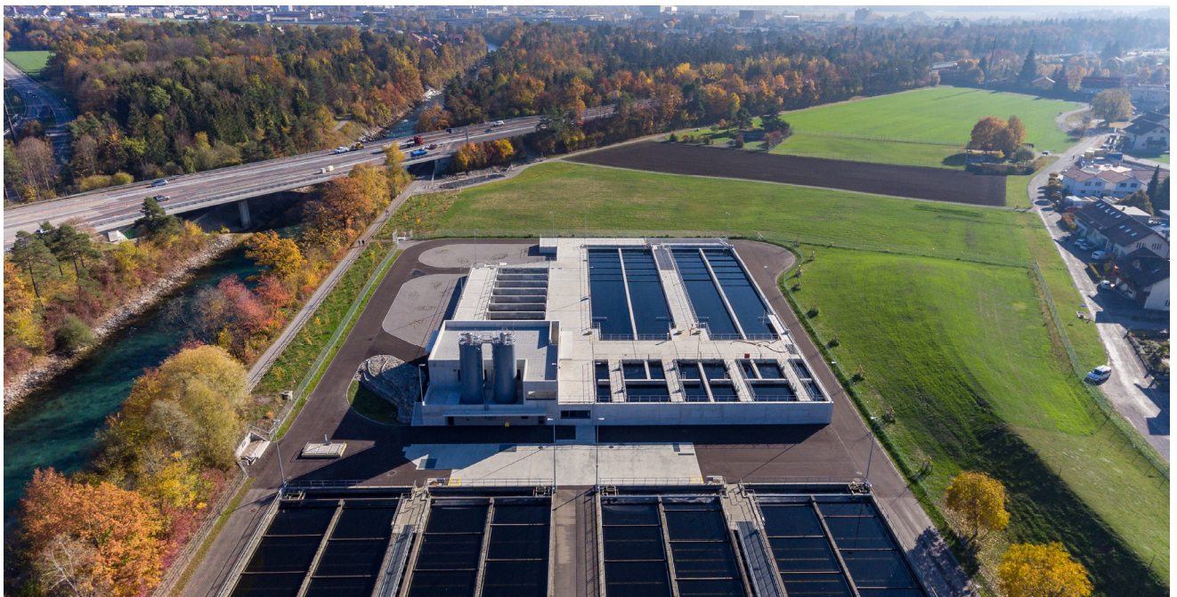
Abbildung 2: Luftansicht des neuen Anlageteils
