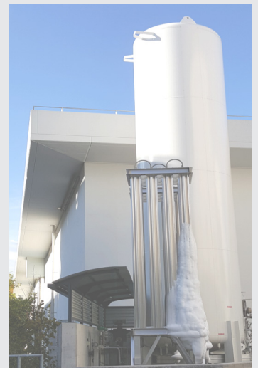
Reinsauerstofftank mit Verdampfer
