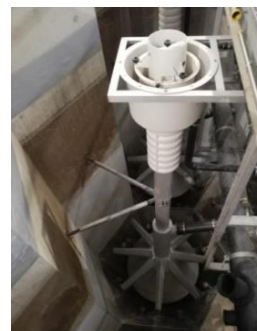
Filtereinheit "DynaSand" ohne Filtermaterial
