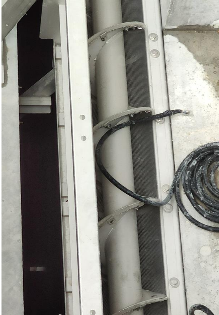
Abbildung 2: Sieb im Zulauf zum GAK im Schwebbett – hält grobe Feststoffe wie Laub oder Algen zurück, Foto A. Brander
