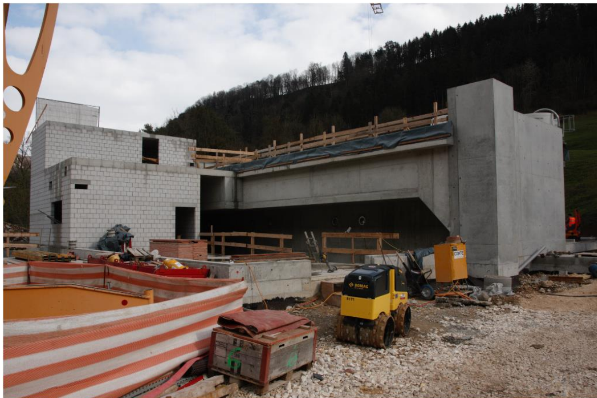
Abbildung 2 – Kläranlage Delémont, GAK im Schwebebett, Bauzeit, Quelle: J. M. Seuret
