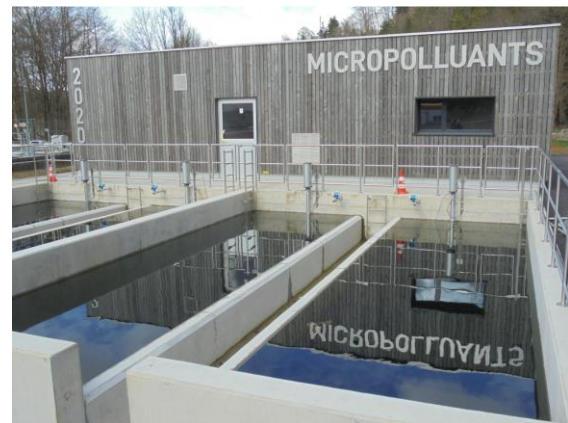
Figure 7: Ozonation STEP de Porrentruy (photo : RWB Groupe SA)
