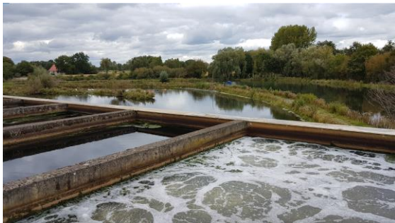
Figure 8: filtration sur charbon actif en grains à la STEP d'Obere Lutter (Photo: Hunziker Betatech)
