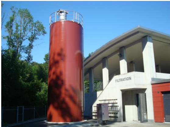
Figure 6: Silo de CAP et filtration à la STEP d'Egg-Oetwil (photo: Hunziker Betatech AG)
