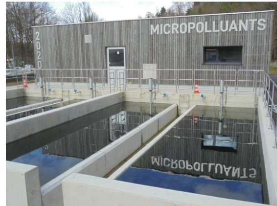
Abbildung 7: Ozonung ARA Porrentruy (Foto : RWB Groupe SA )
