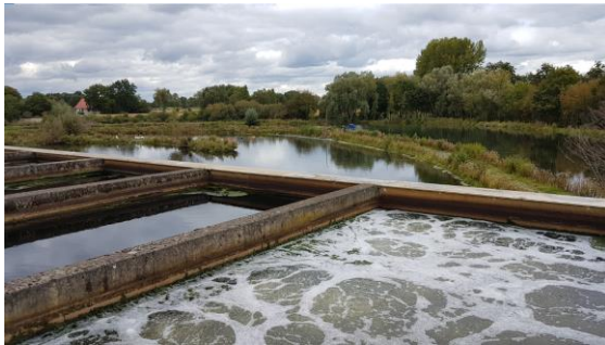
Abbildung 8: GAK-Filtration Klärwerk Obere Lutter (Foto: Hunziker Betatech)
