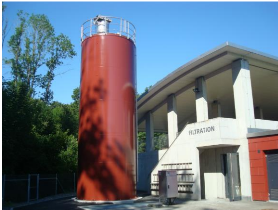
Abbildung 6: PAK-Silo und Filtration der ARA Egg-Oetwil (Foto: Hunziker Betatech AG)
