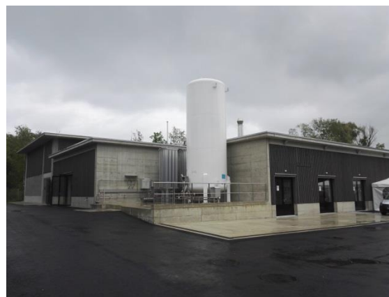
Figure 4 : Étape MP à la STEP d'Altenrhein avec un réservoir d'oxygène liquide au premier plan
