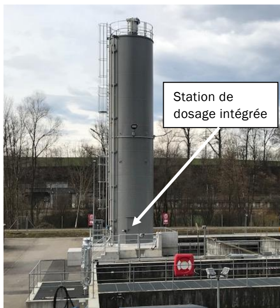
Figure 2 : Silo de CAP à la STEP de Wetzikon
