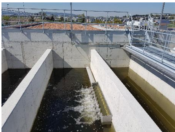
Fig. 6: Toit du nouveau bâtiment avec la filtration sur sable au premier plan (STEP d'Eich, Bassersdorf)
