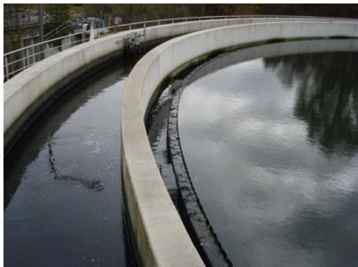
Figure 3: exemple d'un bassin combiné circulaire à la STEP de Böblingen-Sindelfingen (Allemagne): zone de contact dans le cercle extérieur, zone de sédimentation à l'intérieur (photo : plateforme)
