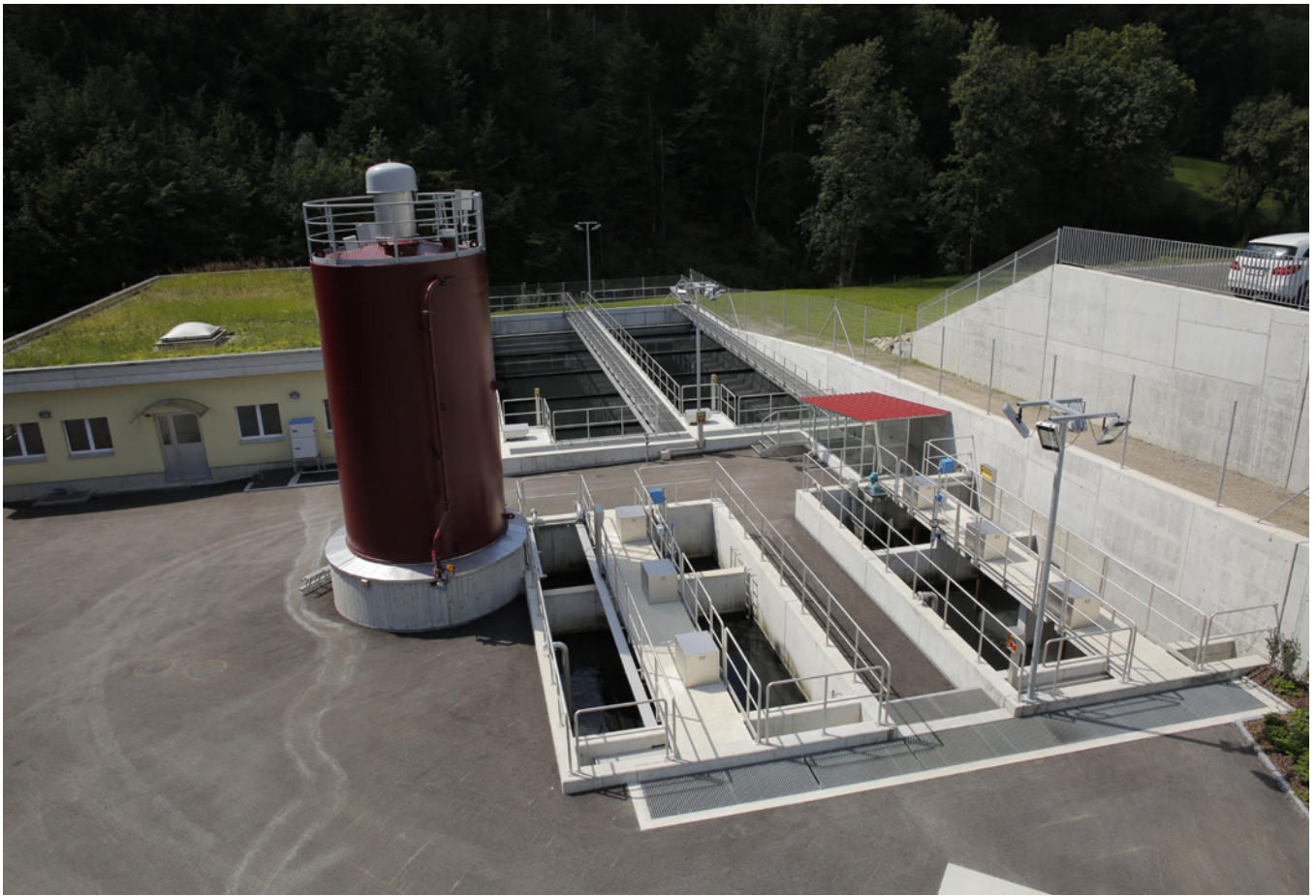
Pulveraktivkohle-Stufe der Abwasserreinigungsanlage (ARA) Bachwis in Herisau. Das Foto zeigt das Pulveraktivkohle-Silo (rot), und den Kontaktreaktor im Vordergrund. Hinten rechts die Sedimentationsbecken, links die Filtration
