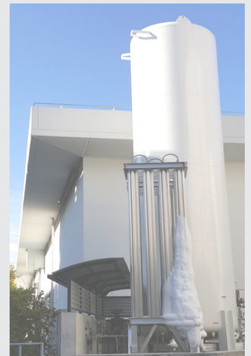
Reinsauerstofftank mit Verdampfer
