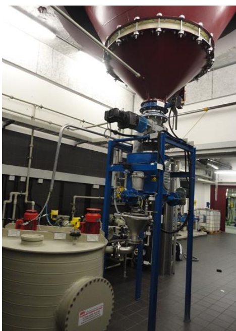
Abbildung 6. PAK-Dosierstation ARA Bachwis (Herisau).
