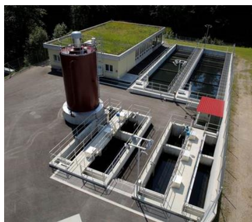
Abbildung 5. Realisierte PAK-Stufe nach dem Ulmer-Verfahren auf der ARA Bachwis (Herisau).
