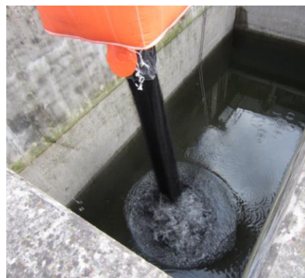
Abbildung 4. Einfüllen der GAK in die Filterzelle.
