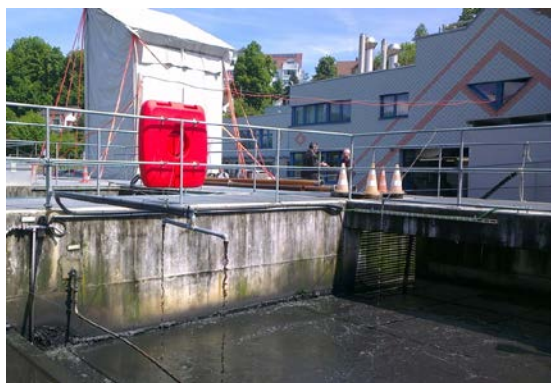
Abbildung 1: PAK-Direktdosierung in die Biologie der ARA Flos, Wetzikon.
