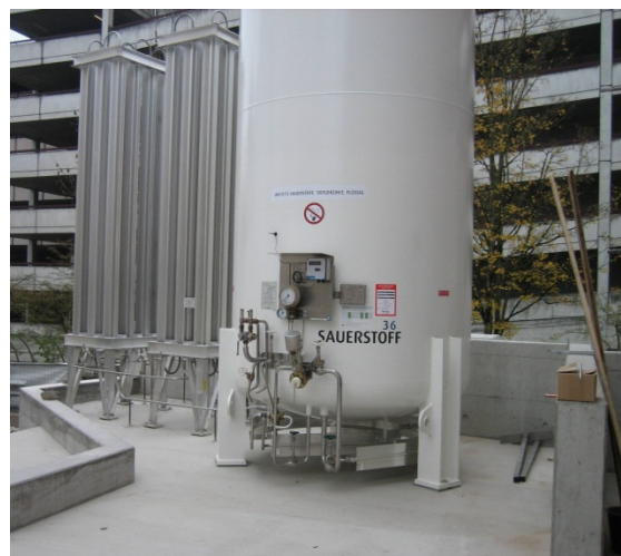
Abbildung 3: Sauerstofftank und Verdampfer der ARA Neugut in Dübendorf (Bild: Holinger AG)
